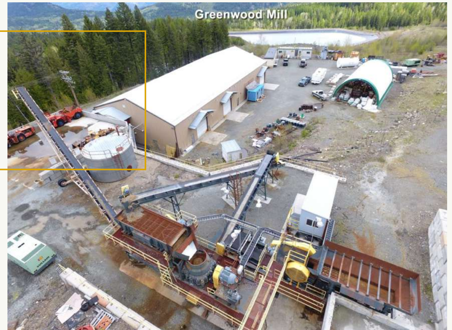
Permitted Greenwood Mill - 200 Ton / Day Capacity 获得许可的Greenwood加工厂 – 日产能200吨 Lined Tailings Pond 尾矿池
