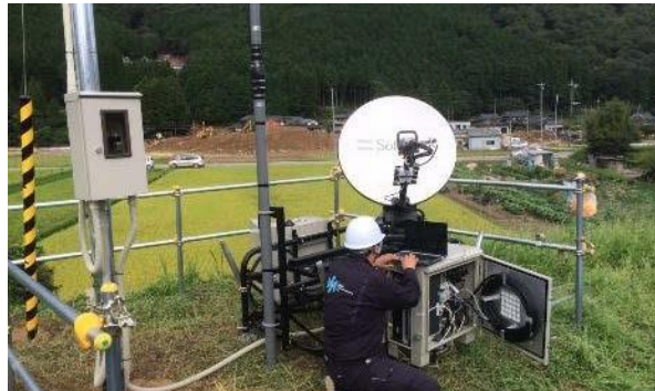
Landslide Disaster JSC Japan - 980 日本山體滑坡災害
